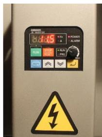
6. Los botones de control del regulador son los 2 botones (verde y rojo) y el regulador a mano derecha. Los botones inferiores son solo de configuración. Importante leer manual Omron proporcionado con la maquina antes de utilizar estos botones.
